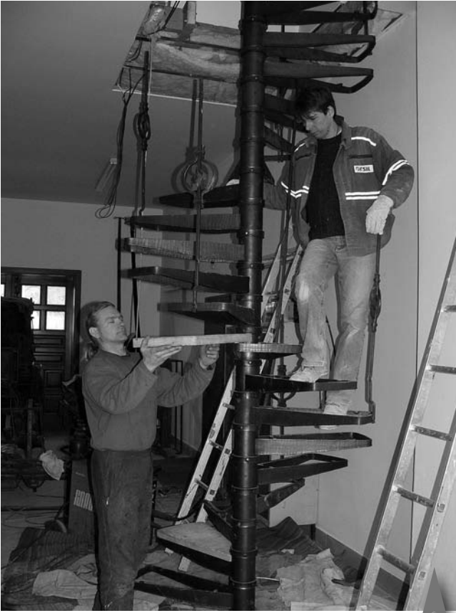
Ač by se to mohlo zdát, schody nevedou do nebe, ale do patra, kde bude další galerii expozice kočárového muzea pokračovat. Schody vyrobili umělci kovárň chlapi Stawaritschovi z Kostelce. Jak nejlíp rozhodli vějíř jednotlivých stupňů i lámalu Václav Obr (na zemi) i stavbyvedoucí Jan Svoboda.
