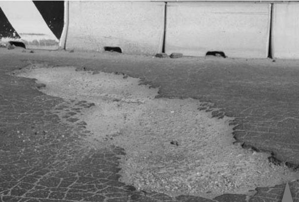
Už je načas. Od tohoto dne probíhají opravy výtluků na rondelu u nové nemocnice.
