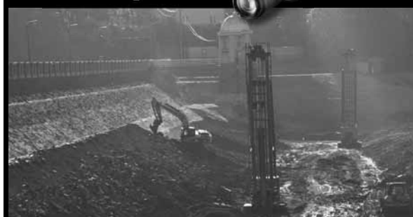
A práce se dělá! Bagr na přehradě odstraňoval obložení hráze, vrtné soupravy zůstávaly v klidu.
