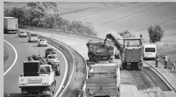
Komplikace. Ve středu se na dálnici z Prostějova do Olomouce, kromě série nehod, frézoval i starý povrch komunikace. Foto: Michal Kadlec
