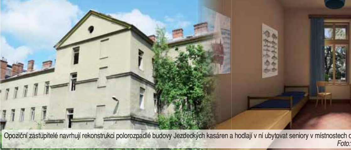
Opoziční zastupitelé navrhují rekonstrukci polorozpadlé budovy Jezdeckých kasáren a hodlají v ní ubytovat seniory v místnostech o Foto: I
