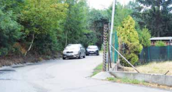
Pozemek se zahrádkou, kvůli kterému byla cesta k „myši díře“ nebezpečná, je už v majetku města. Přístří rok se tady silnice rozšíří a „porovná“.
