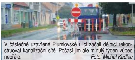
V částečně uzavřené Plumlovské ulici začali dělníci rekonstruovat kanalizační síť. Počasí jim ale minulý týden vůbec nepříšlo. Foto: Michal Kadlec
