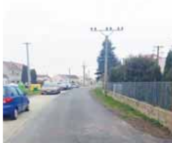
Silnice v Třebízského ulici se dočkala nového povrchu. Foto: Facebook
