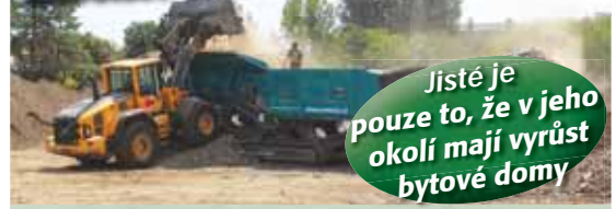
Na ploše uvolněné po demolici jezdeckých kasáren už před lety proběhla recyklace a odvoz stavebního odpadu ze zbořených budov. Foto: archiv Večerníku
