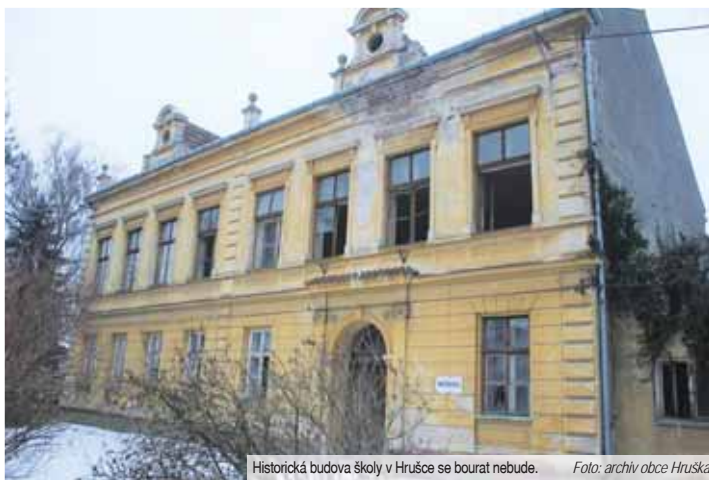
Historická budova školy v Hrušce se bourat nebude. Foto: archiv obce Hruška
