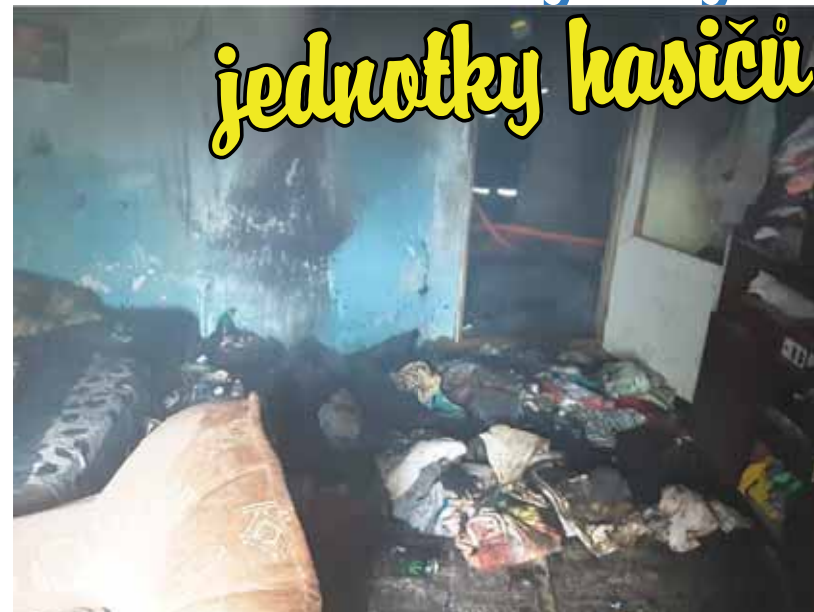
Při požáru v Mořicích došlo ke zranění dvou osob
