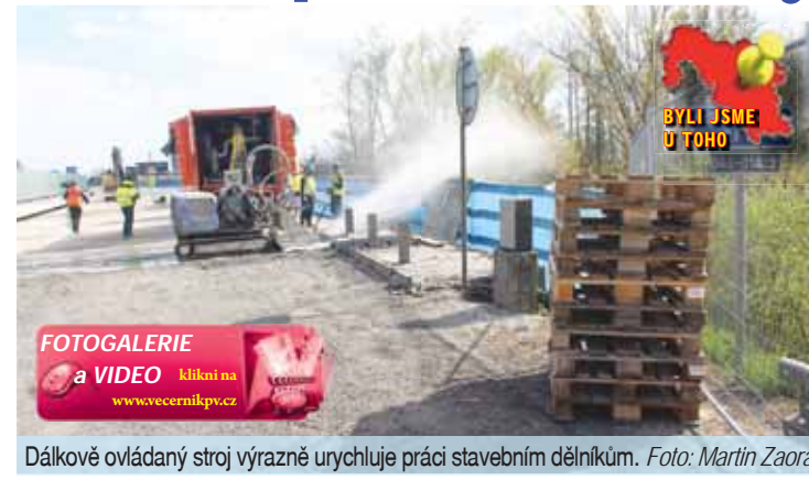
Dálkově ovládaný stroj výrazně urychluje práci stavebním dělníkům. Foto: Martin Zaoral
