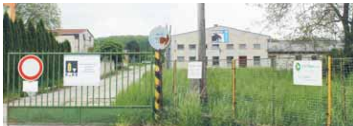
Moderní třídírna odpadů by mohla vzniknout v areálu opuštěného zemědělského družstva na samém okraji nevelké obce. Foto: Martin Zaoral
