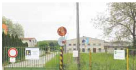
Na okraji Biskupic se nachází poměrně rozlehlý areál opuštěného zemědělského družstva. Jaké bude jeho další využití, zůstává otázkou, třídění odpadů si zde místní nepřejí.
