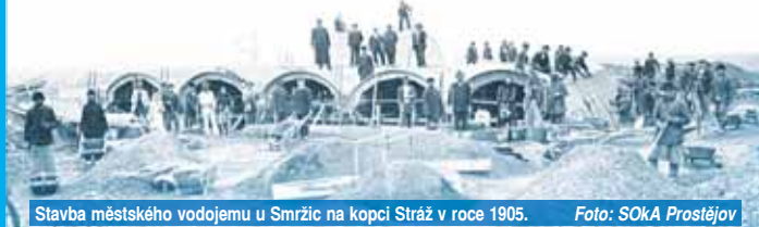
Stavba městského vodojemu u Smržic na kopci Stráž v roce 1905.
