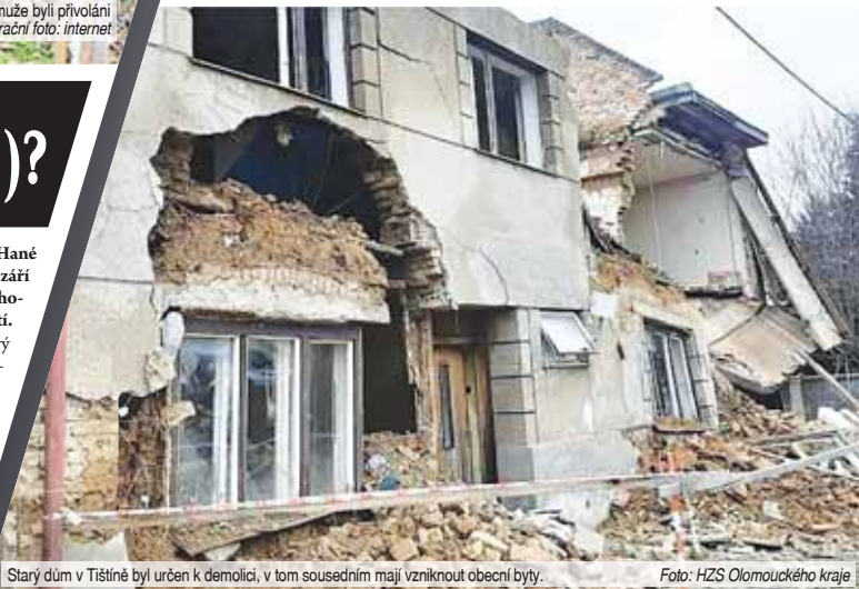
Starý dům v Tištině byl určen k demolicí, v tom sousedním mají vzniknout obecní byty.
