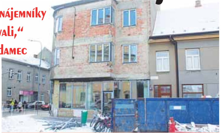
Aktuálně v domě na rohu ulice Újezd probíhá rozsáhlá rekonstrukce, okna již byla vyměněna, nyní by měla přijít na řadu také fasáda. Foto: Martin Zaoral
