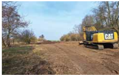
Stavební práce Za Cihelnou v Určické ulici v Prostějově jsou v plném proudu. Foto: www.rozvijimeprostejov.eu
