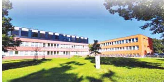
Jedna z fotovoltaických elektráren je již vybudována na budově ZŠ Jana Železného. Foto: Magistrát města Prostějova
