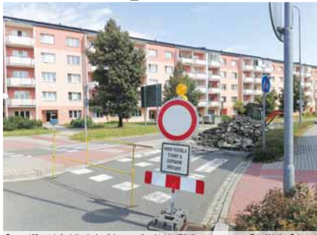
Oprava 165 metrů dlouhého úseku silnice se podle místních plísnil táhnou.
