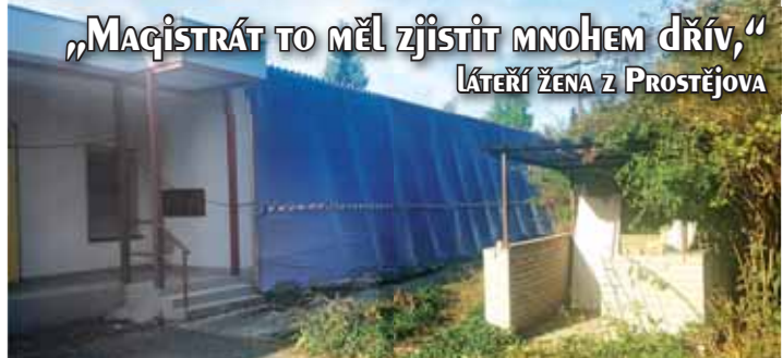
Kvůli přítomnosti azbestu musely být objekty určené k demolicí zabezpečeny.
