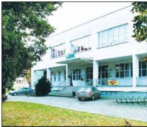
Podle mnohých je životnost prostějovských lázní už takzvaně na hraně. Jaké mají v budoucnu najít využití, v tom mají pomoci studenti architektury. Foto: archiv Večerníku
