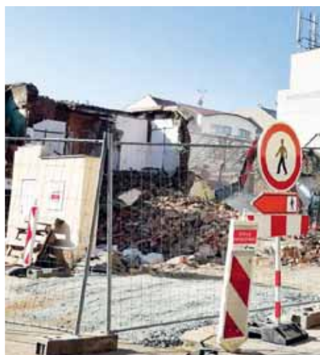
Dvorní trakty obou domů byly v pátek již demolovány.
