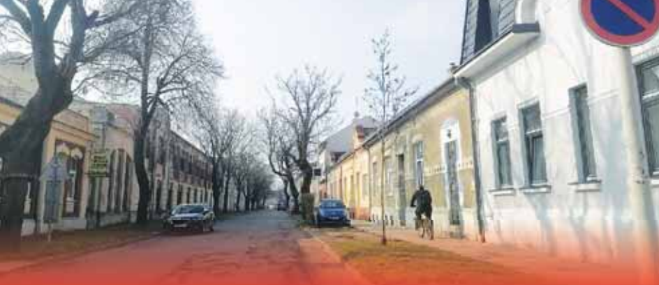
V Českokobratrské ulici je ve špatném stavu silnice, lépe na tom nejsou ani chodníky.
