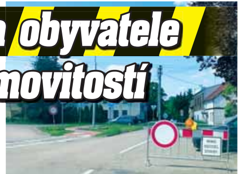
Rekonstrukce komunikace přijde kraj na 7,1 milionu korun. Foto: Kristýna Bohatová
