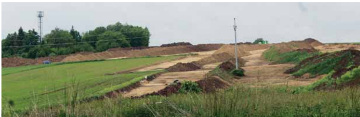
Počátek výkopových prací je vidět v okolí Němčic nad Hanou již nyní, v červnu se vše rozjede naplno.
