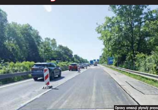
Opravy omezují plynulý provoz na dálnici D46. Foto: RSD
