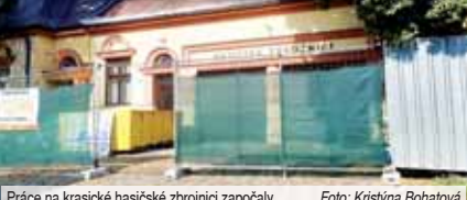
Práce na krasické hasičské zbrojnici započaly.
