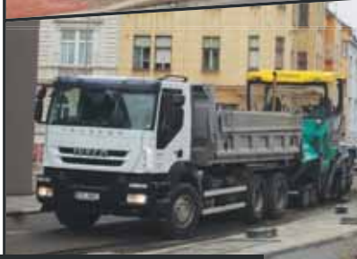
Zatímco provoz terminálu byl oficiálně zahájen, v jeho okolí se stále ještě usilovně pracovalo.
