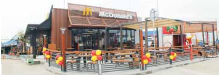
McDonald's otevřel v novém objektu naproti OC Arkáda v Držovicích.
