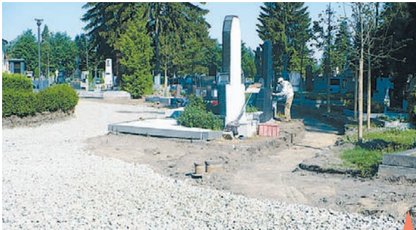
Postupně se pracovníci společnosti A.S.A. pustili do výsadby nové zeleně a náložky podloží pro nové komunikace
