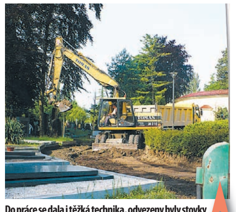
Do práce se dala i těžká technika, odvezeny byly stovky kubiků hlíny
