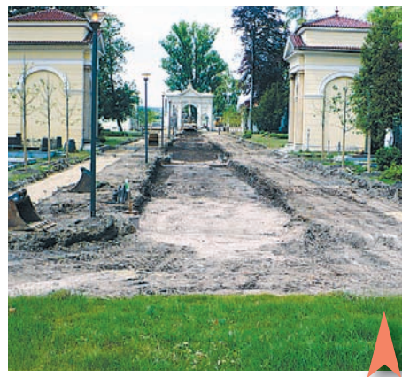
Na začátku května se na hřbitově začalo kácet a rozkopávat...
