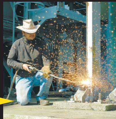
Robert Výmola dobře ví, jak podobným kolosům "podříznout" nohy, aby padly tam, kam mají.
