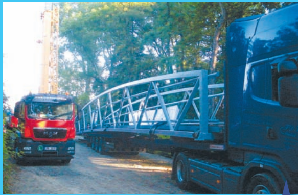
Po zhruba hodině doputoval patnáctitunový ocelový kolos z DT Mostárny až k samotnému místu určení. Bravo šoféře!
