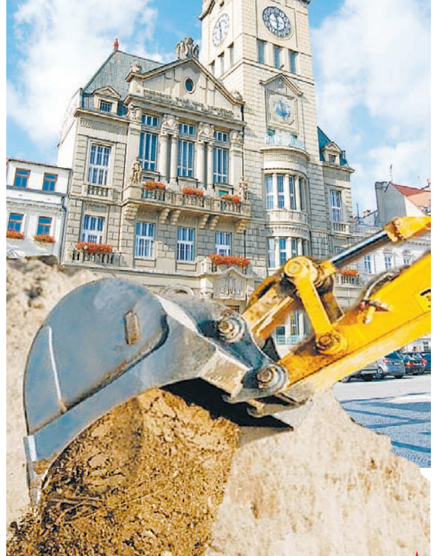
V následujících dvou letech bude město doslova zavaleno hlínou z mnoha výkopů kvůli totální rekonstrukci kanalizace
