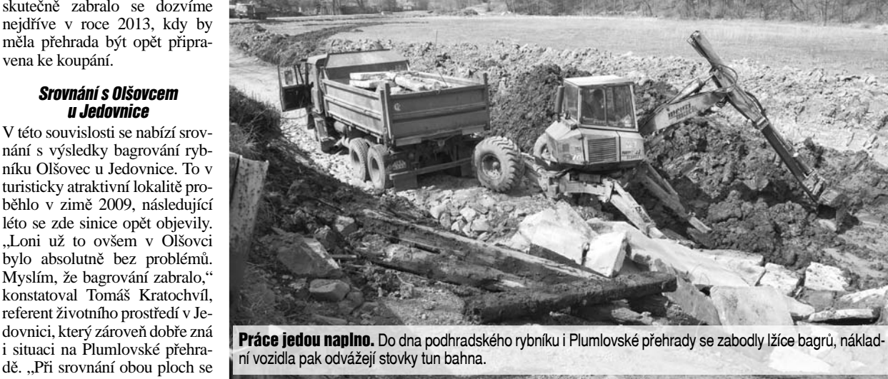
Práce jedou naplno. Do dna podhradského rybníku i Plumlovské přehrady se zabodly lžice bagrů, nákladní vozidla pak odvázejí stovky tun bahna.
