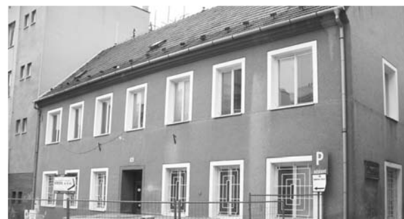
Zatím v rekonstrukci. Objekt v Demelově ulici, kde dříve sídlila Domovní správa, se v současnosti opravuje. Miliony korun zatím proudí do cizího majetku, město ale jedná s Židovskou obcí o odkupu nemovitosti. Foto: Michal Kadlec
