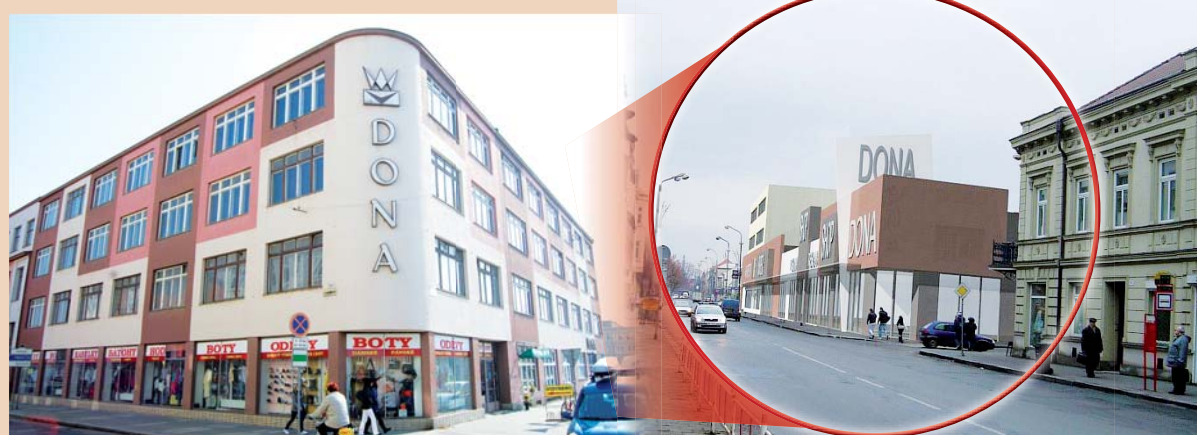
Místo Dony nové obchodní centrum. Stávající objekt ve Svatoplukově ulici brzy bude zbourán. Měl ho nahradit jiný soubor staveb, jehož projekt vzbudil odpor nejenom u běžných občanů, ale také u představitelů radnice. Původní projekt nového obchodního centra, v podobě jak ho vidíme na druhém snímku, slíbili vietnamští majitelé přepracovat. Foto: Kolář PV Večerníku
