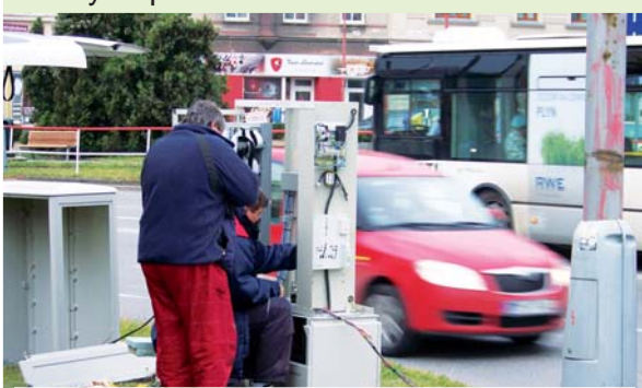
Už to brzy bude. Pracovníci specializované firmy ve středu instalovali na křižovatce mezi Újezdem a Olomouckou nový řadič. Pár hodin nato začaly konečně újezdat semafore. Foto: Michal Kadlec
