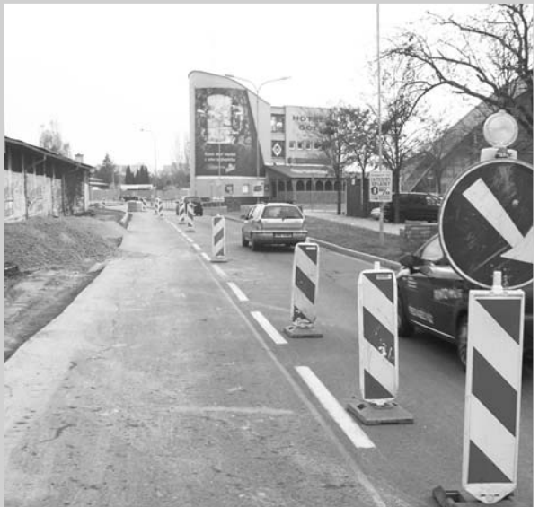
Omezení u zimáku. Kvůli stavbě cyklostezky je v ulici U Stadionu omezen dopravní provoz. Foto: Michal Kadlec
