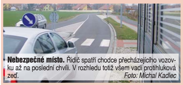
Nebezpečné místo. Řidiči spatří chodce přecházejícího vozovku až na poslední chvíli. V rozhledu totiž všem vadí protihluková zeď. Foto: Michal Kadlec
