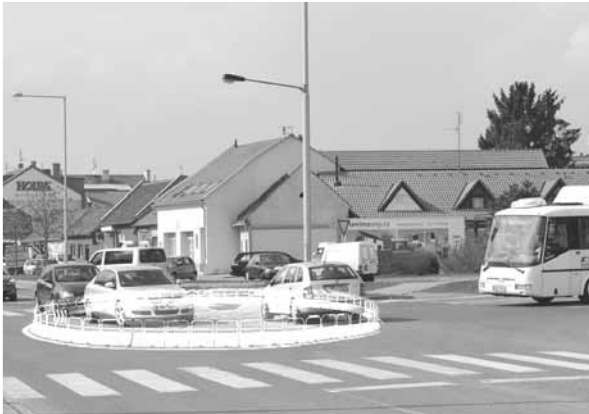
Problémové místo. Klasická křižovatka U Rodenů už kapacitně nestačí. Rondel je jediným řešením, byť půjde o provizorium. Foto: Michal Kadlec
