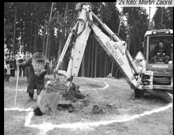
Senátora nahradil bagr. Senátora a stále ještě hejtmána Olomouckého kraje ohánějího se krumpáčem při stavbě rozhledny brzy nahradí bagr, na jehož práci pečlivě dohlížel i Kosířan.
