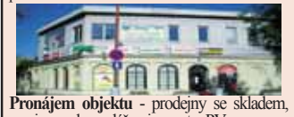
Pronájem objektu – prodává se skladem, servisem a kancelářemi v centru PV. SLEVA: 40 000Kč/měs. + DPH + inkaso
