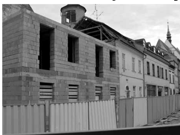
Pod dohledem. Stavbaři při budování replik židovských domů za bývalým Prioem jsou kontrolováni památkáři. Foto: Michal Kadlec
