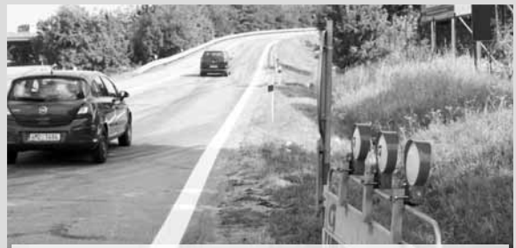
Hotovo, otevřeno. Rekonstrukce vozovky na estakádě Haná byla ukončena, řidiči tak mohou opět nájždět směr Brno! Foto: M. Kadlec
