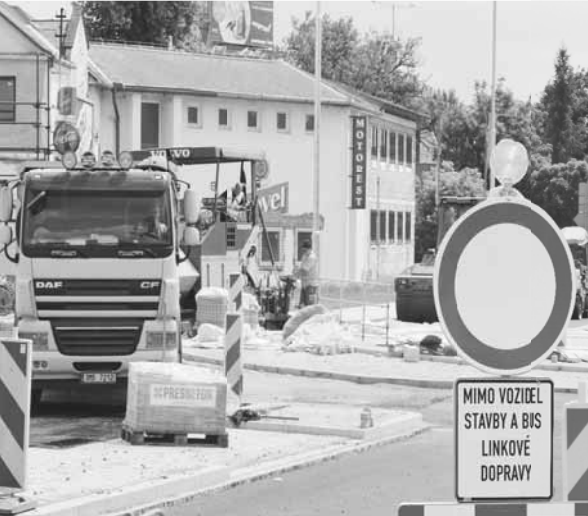
Už se rýsuje. Rondel u známého motorestu bude nakonec stálý a jestli stavbaři práce urychlí, už tento pátek by mohla být Dolní ulice v Prostějově kompletně zprovozněna. 2x foto: Michal Kadlec
