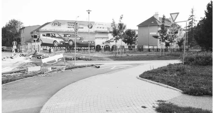
Raději se dejte doprava. Kdo nechce riskovat přechod přes staveniště, měl by se dát po cyklostezce směrem k Místnímu nádraží. Foto: Martin Zaoral
