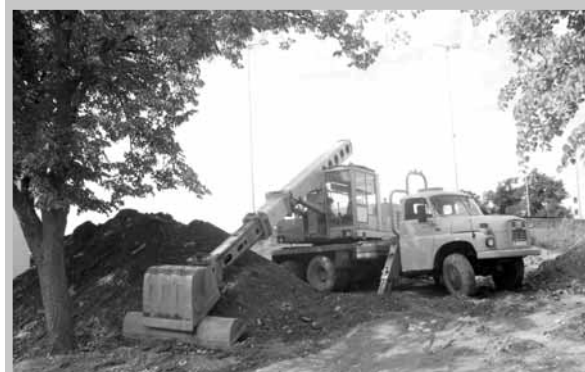
Dohání se zdržení. Dělníci u velodromu už čile pracují na stavbě nové bikrosové dráhy. Foto: Jiří Možný
