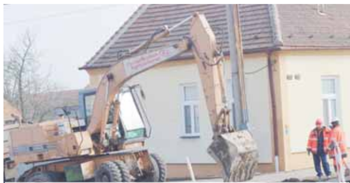
S budováním kanalizace ve Ptení se začalo už před několika týdny. Foto: Martin Zaoral
