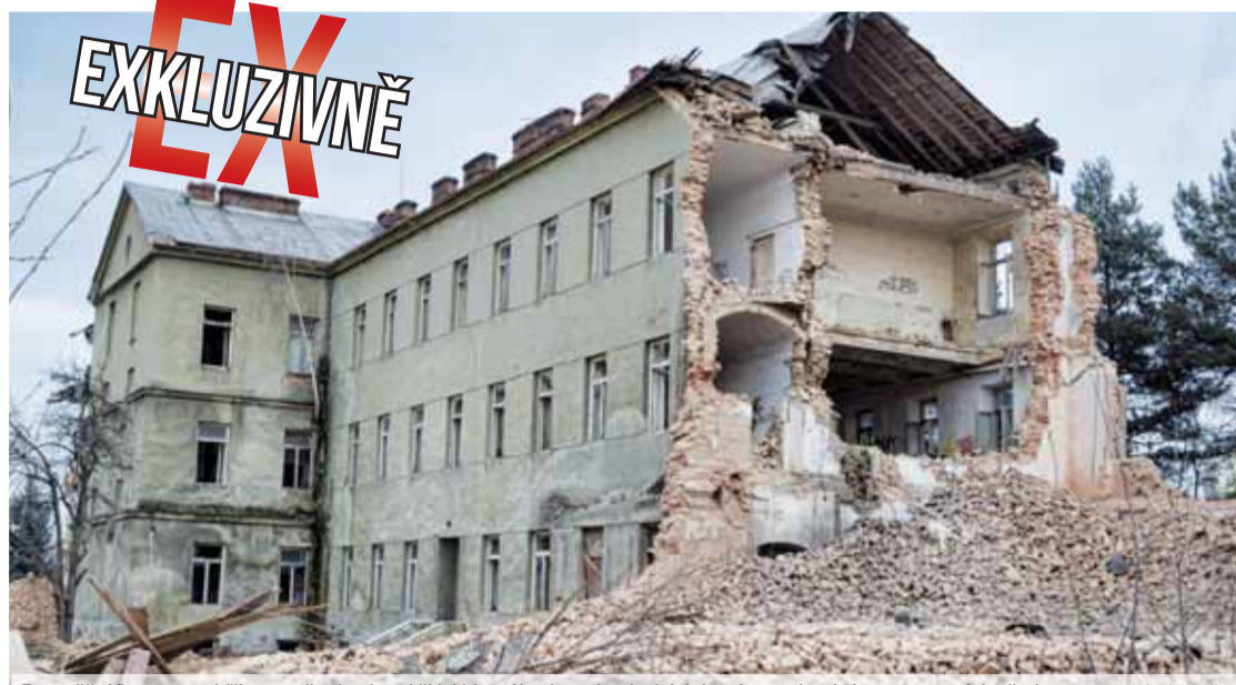
Demoliční firma se nejdříve pustila do obou křídel hlavní budovy Jezdeckých kasáren, zůstaly jen tury starých chřel. Foto: Michal Kadlec
