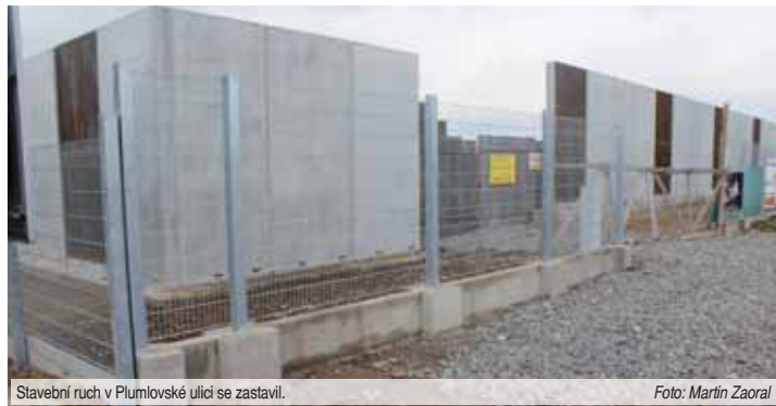
Stavební ruch v Plumlovské ulici se zastavil.
