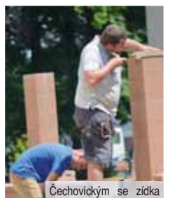
Čechovickým se zídka s betonovým soklem nelíbí. Firma se ale brání tím, že při stavbě postupuje přesně podle stavebního projektu. 2x foto: Michal Kadlec
