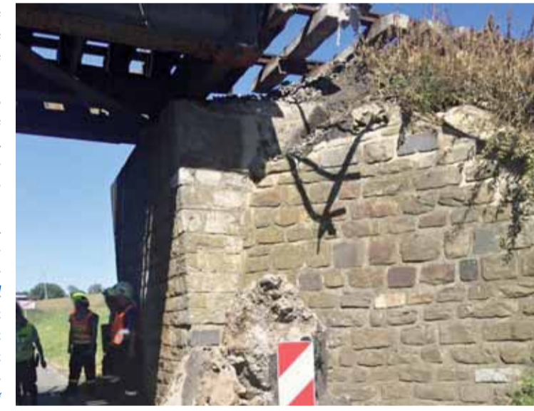
Hrůzná nehoda zcela ochromila nejenom silnici, ale hlavně železniční dopravu. Na jednom ze snímků je vidět, jak náraz ponížil koleje a most vyhnul o bezmála dva metry. 2x foto: HZS Olomouckého kraje
