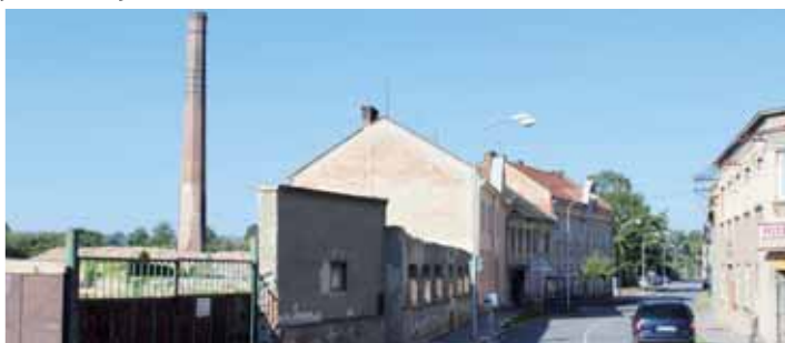
V areálu bývalého cukrovary se dokončuje demolice. Komín by měl zůstat zachován, o jeho zbourání se ale posledních informací neuvažuje. Foto: Martin Zaoral
