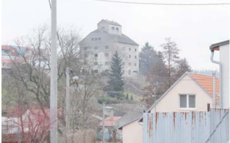
Zchátralý objekt bývalého síla stojí na hlavním konickém náměstí za „Novou lékárnou“. V současné době již prochází rozsáhlými stavebními úpravami. Foto: archiv Večerníku
